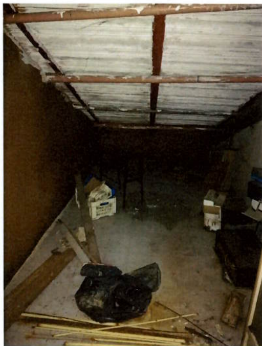
Foto n. 35 – INTERNO P. sottotetto
