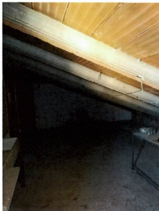
Foto n. 39 – INTERNO P. sottotetto
