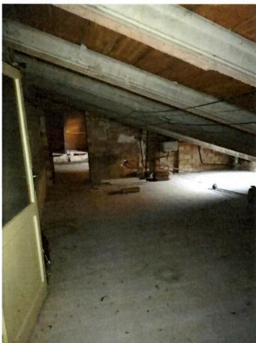
Foto n. 36 – INTERNO P. sottotetto
