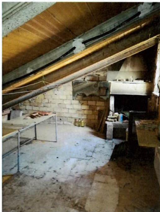
Foto n. 38 – INTERNO P. sottotetto
